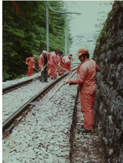
Handwerklich anspruchsvoll: Gleisbauarbeiten im Jahr 1980. Bild: PD / Müller Frauenfeld AG
